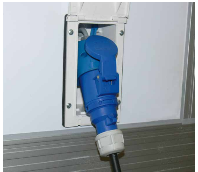
Einspeisesteckdose CEE 230 V / 16 A außen
